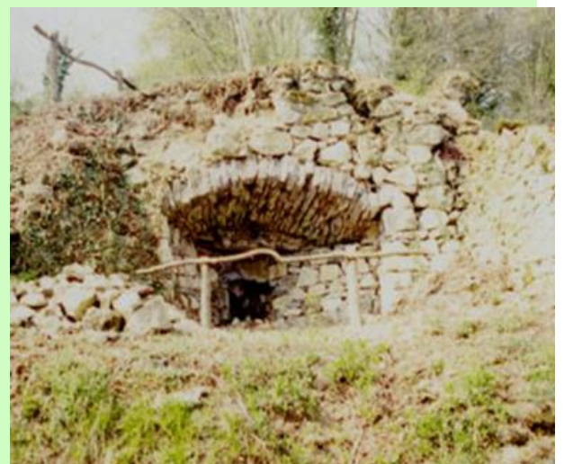
Bouche (ou la geule) de défournement
