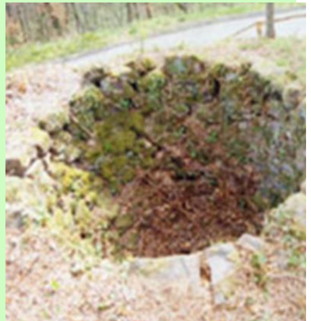
La chaudière du four et au sommet le geulard
